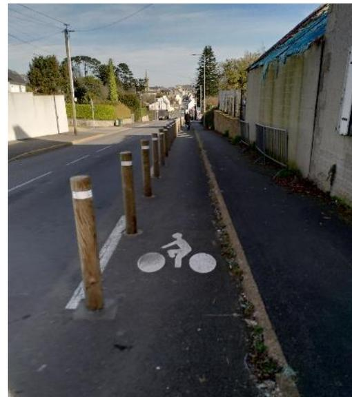
Piste cyclable à Landivisiau, avenue de la Libération. Les potelets permettent une réelle séparation entre les flux motorisés et les cyclistes. La hauteur des potelets et la fréquence de leur implantation rend cependant l'aménagement moins confortable et diminue sa largeur disponible.
